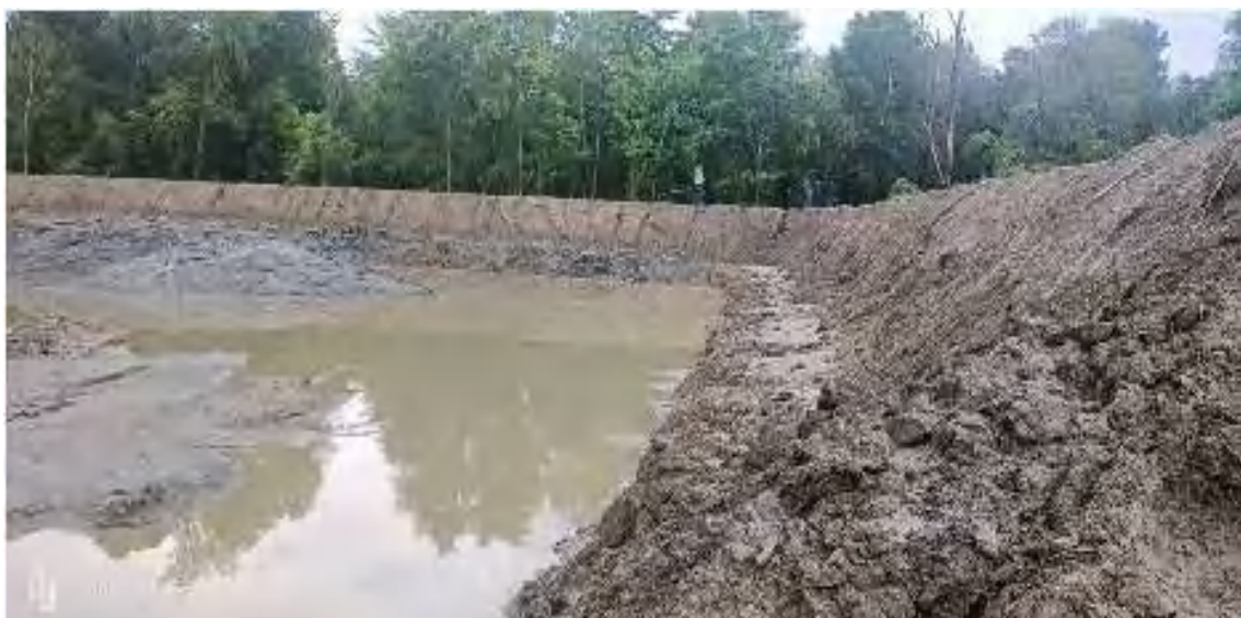
टिकुलीगढी सा.ब. भित्र निर्माण गरिएको पोखरी
